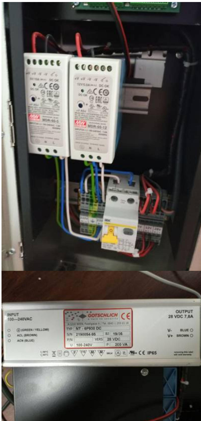
Блок управления Logiturn и подключения валидатора, платы конца прохода
